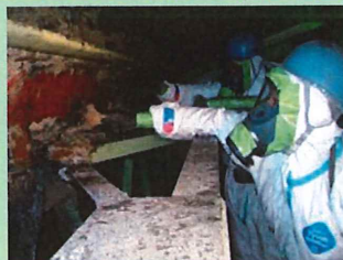
吹付け石綿の除去作業の様子
